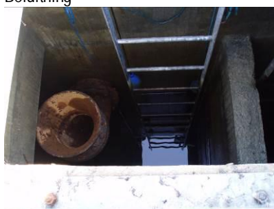
Nedgang til rentvandstank
